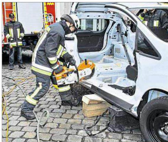
Eine spezielle Motorsäge, Rettungsschere und -spreizer – die Feuerwehr brachte alle Geräte zum Einsatz, die im Ernstfall oft gebraucht werden. Die Überreste des Fahrzeugs können Pfaffenhofener Berufsschüler jetzt zum Lernen verwenden.
