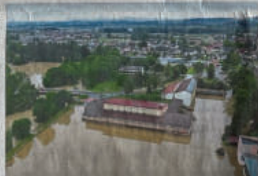
Der Fluss Schussen überschwemmt im baden-württembergischen Meckenbeuren erneut die Schule. Das Gebäude stand erst vor drei Jahren unter Wasser. Foto: Felix Kersch, Karl-Joachim Heidebrecht, dpa
