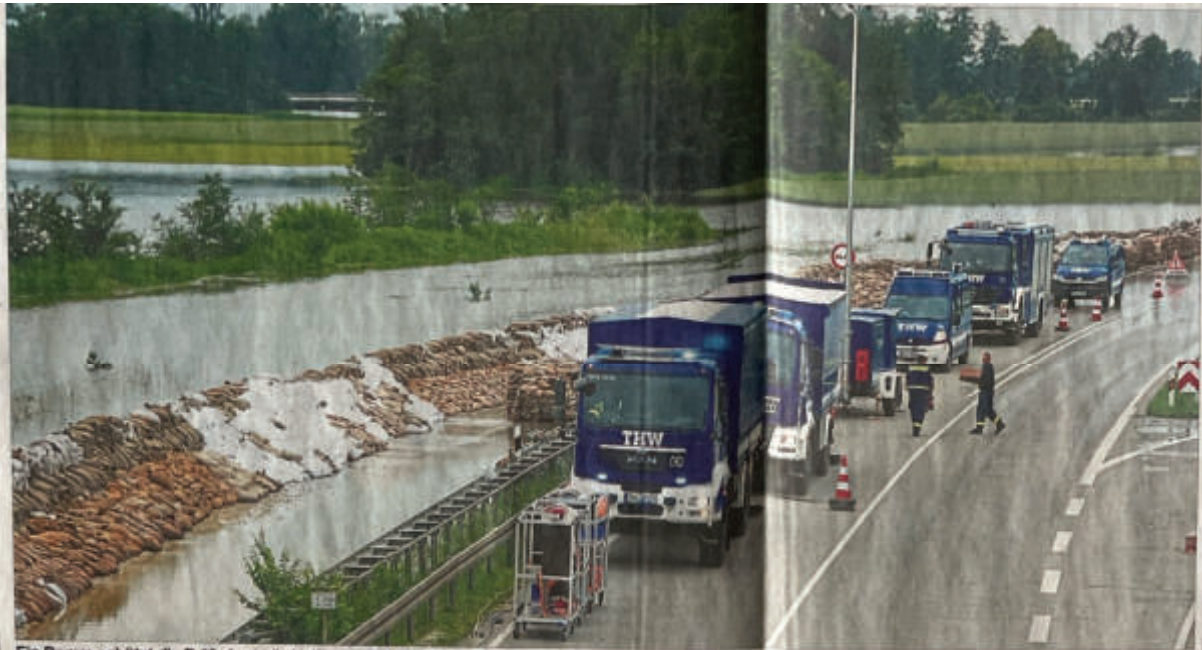
Ein Damm schützt die B 16: Auch die Helfer vom THW hatten und haben vor allem im Norden des Landkreises alle Hände voll zu tun.
