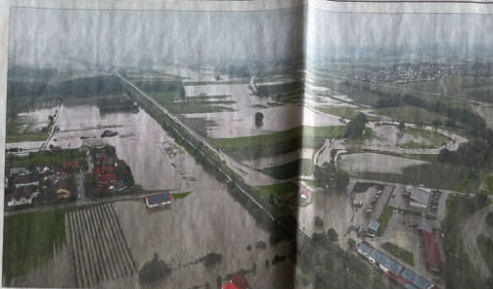
Eine Drohnenaufnahme der Feuerwehr Bobach vom Sonntagvormittag zeigt einen Teil des Ausmaßes der Hochwasserkatastrophe am Wochenende. Die Aufnahme entstand noch vor dem Höchstpegelstand, der gegen Mittag erwartet wurde. In den Fluten ist ein Feuerwehrmann gestorben. Foto: Pat
